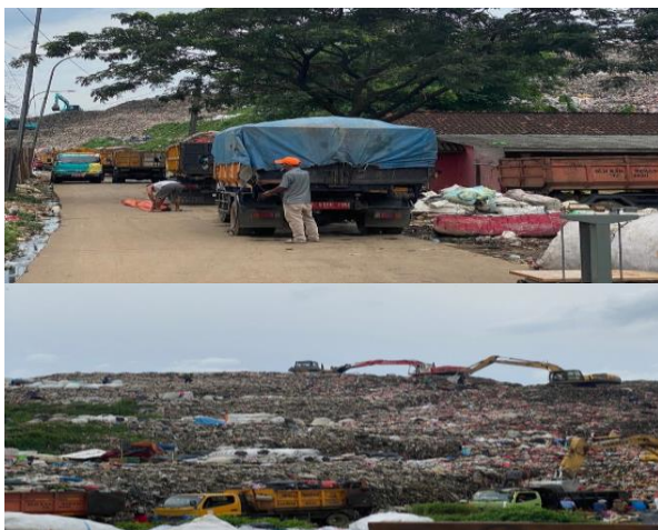
Gambar 2. Penggunaan Sarana dan Prasarana dan Kondisi Penumpukan Sampah Pada TPA Burangkeng
