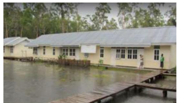
Gambar 2. Ruang Rawat Inap Puskesmas Ngguti
