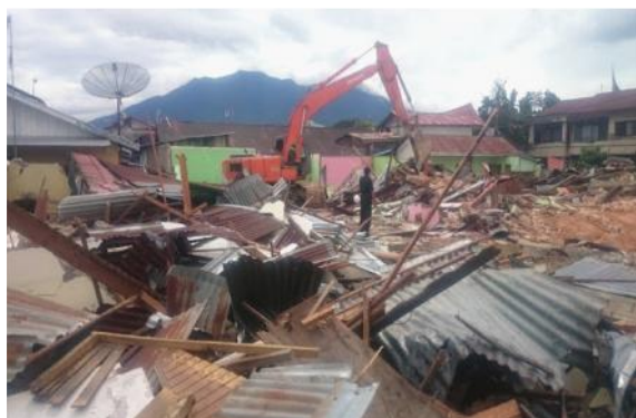
Gambar 1. Pembongkaran Bangunan Masyarakat di Emplasement Stasiun
